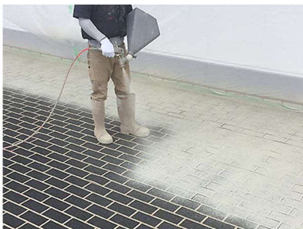
上塗り1層目の吹付け
