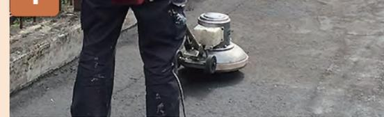
電動ポリッシャーなどによるアスファルトの油分除去、コンクリートのノロやレイタンス除去
