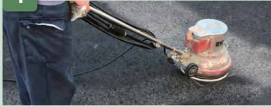
電動ポリッシャーなどによるアスファルトの油分除去、コンクリートのノロやレイタンス除去
